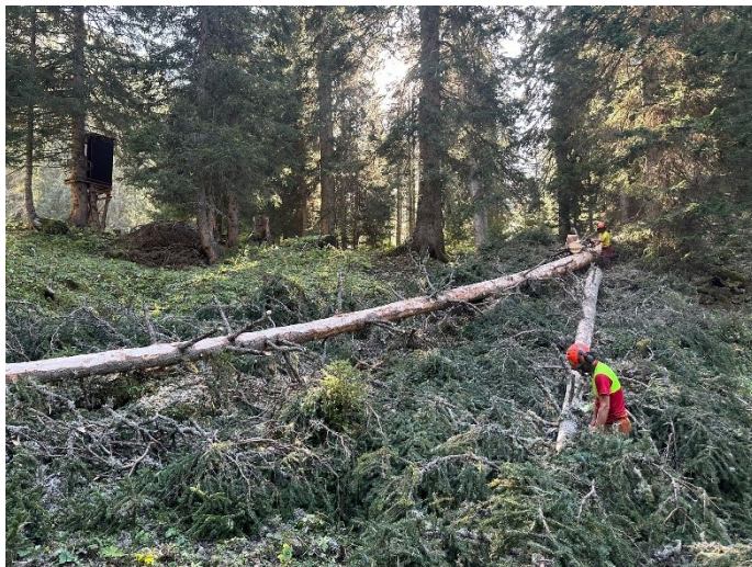
Bild 3: Es mag «unordentlich» erscheinen. Aber das belassen der Äste und der Stämme schafft Lebensräume für Kleintiere, wodurch auch die Artenvielfalt gefördert wird. Die liegenden Holzstämme erfüllen auch eine Schutzfunktion, indem sie als natürliche Barriere gegen mögliche Steinschläge oder Lawinen wirken.
